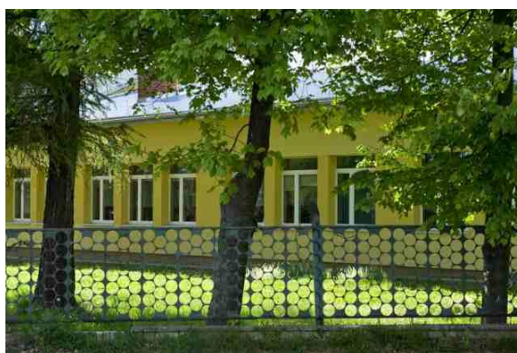
Budynek Zakładu Opiekuńczo-Leczniczego w Oleśnicy, Oleśnica 132, 08-117 Wodnyie
